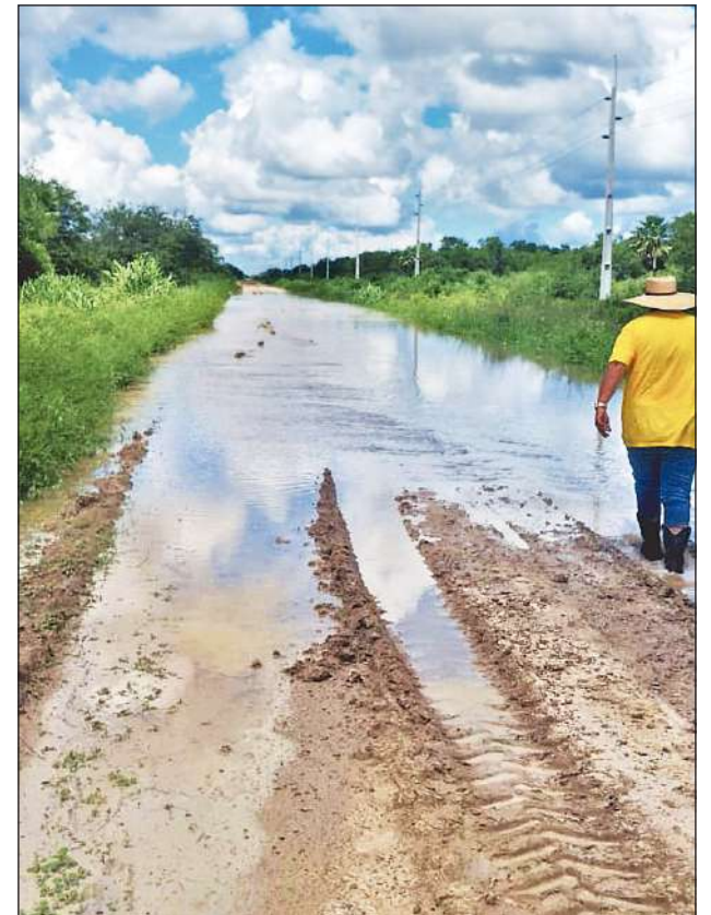
Deuda. Tras cada temporal, aflora la falta de infraestructura vial.
