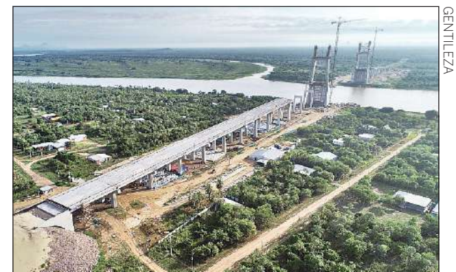
Obras. El Puente de la Bioceánica sigue en construcción.
