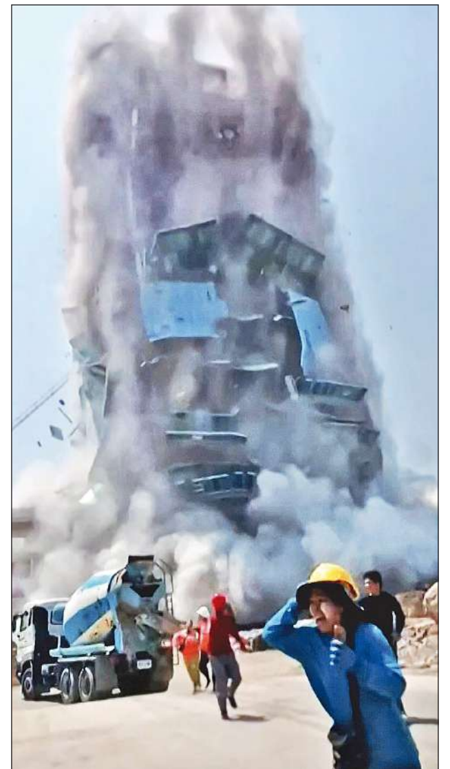
Pánico. Un rascacielos en construcción colapsó con el sismo.
