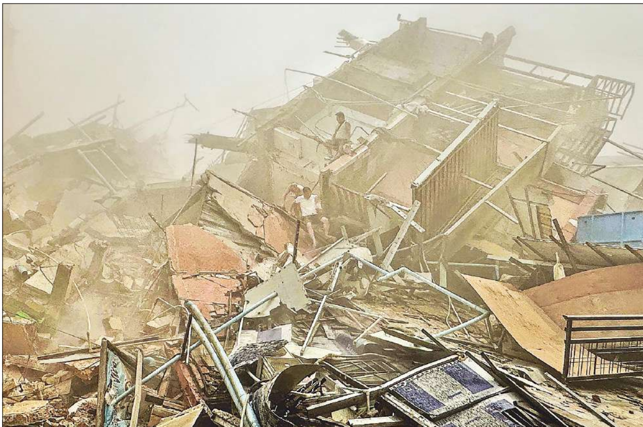
Destrucción. Algunas personas buscaban sobrevivientes entre los escombros de un edificio derrumbado en Mandalay.
