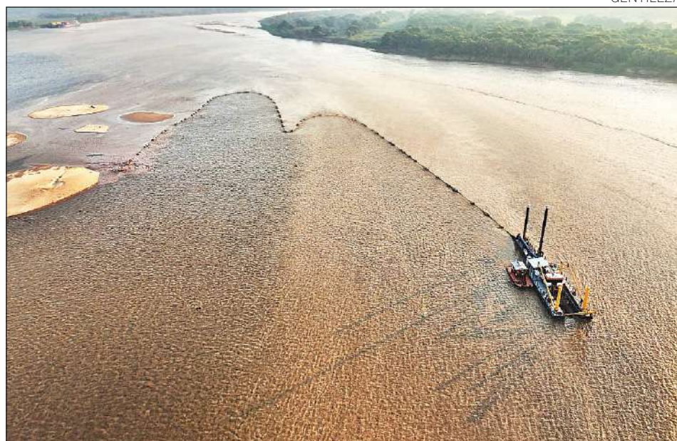
Sedimentos. Unos 25.000 metros cúbicos de sedimentos se retirar a diario.
