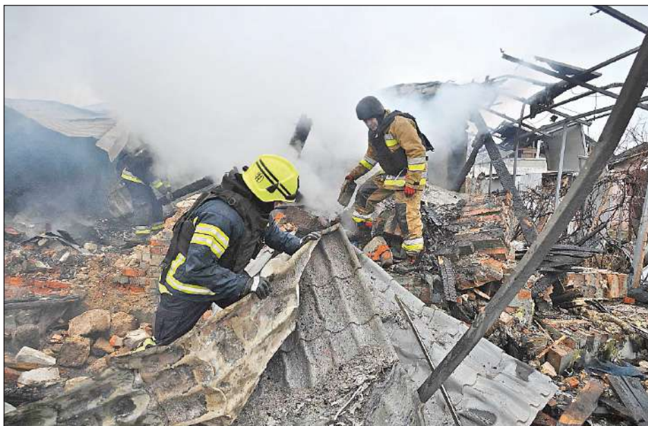
Emergencia. Rescatistas buscan supervivientes en un edificio impactado por bombas.
