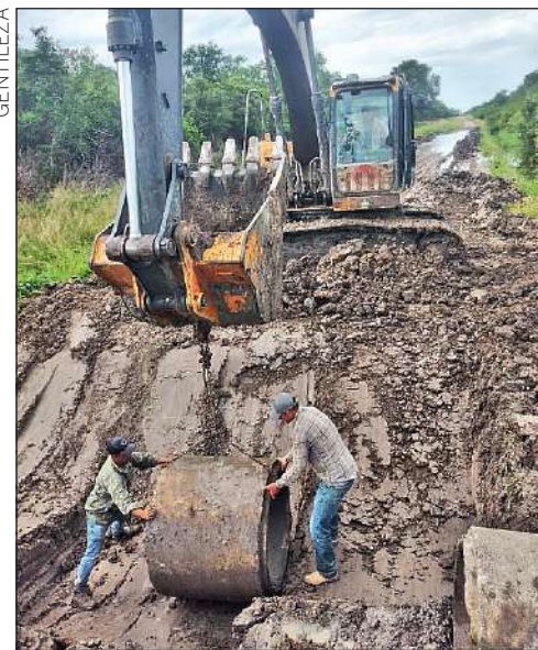
Por fin. En tramos más críticos colocaron tubos de hormigón para que el agua corra en días de lluvia.
