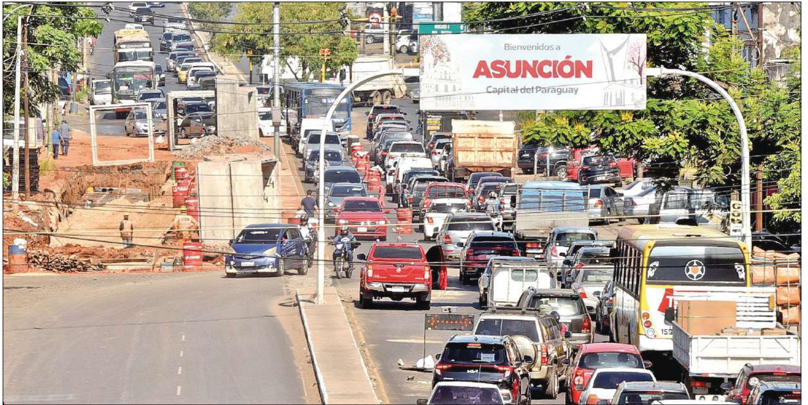
Retraso. Conductores tardan una hora más en su trayecto diario, sobre todo en horas de alta afluencia en la zona del viaducto de Calle Última.
