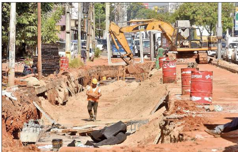
Prolongadas. Las obras en Eusebio Ayala han causado graves pérdidas para los comerciantes, en parte debido a la tardanza en la ejecución.
