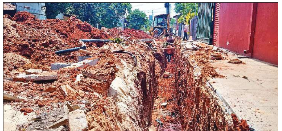
Peligro. Vecinos de la calle Eduardo San Martín piden que las obras culminen pronto.
