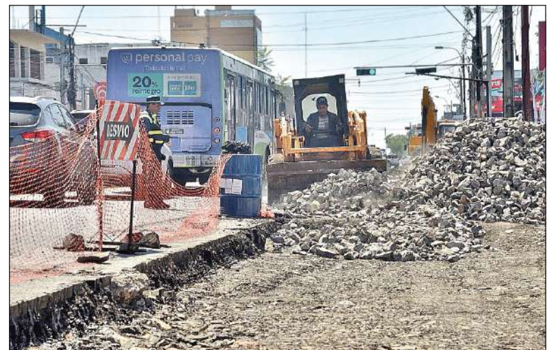
Mejoramiento. Entre las calles Pastora Céspedes y Camilo Recalde se realiza el mejoramiento del pavimento con hormigón hidráulico.
