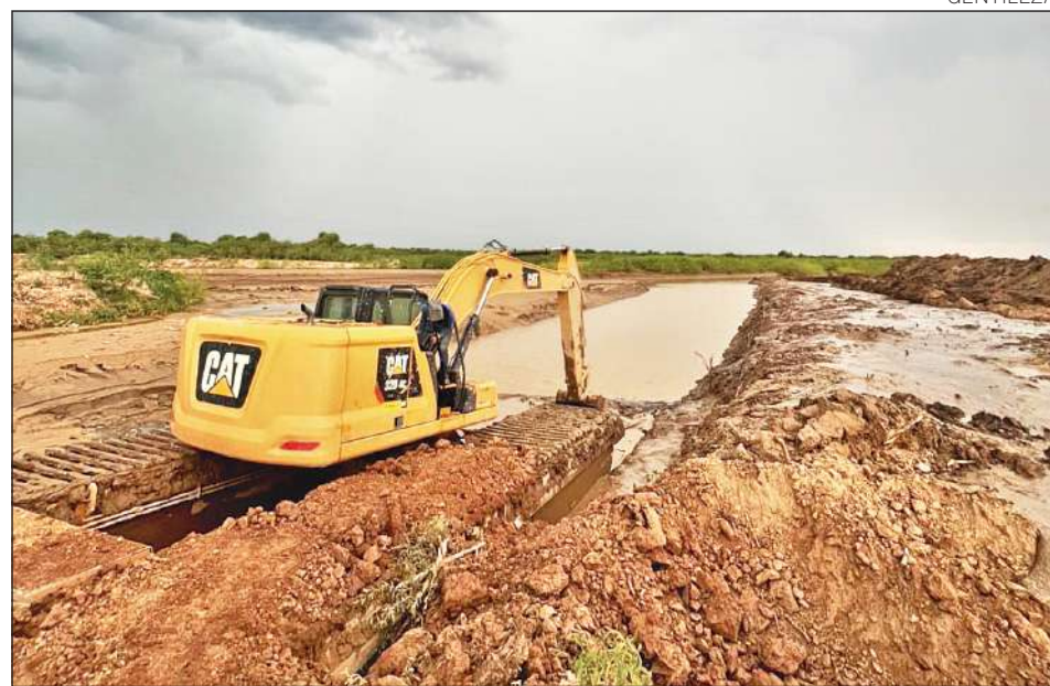
Sedimentos. La limpieza de las bocas y canales del Pilcomayo no se detiene.
