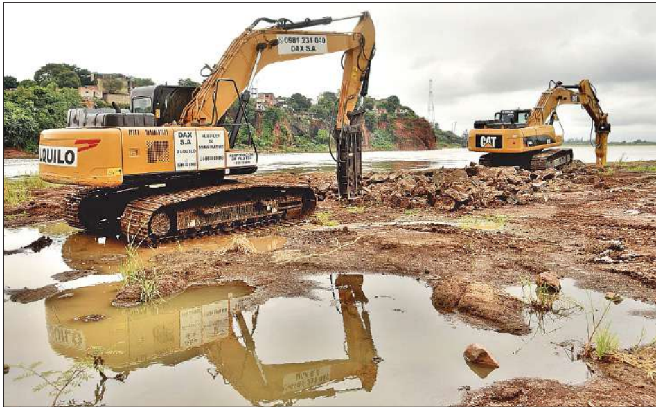
Excavación. Los trabajos de adecuación del canal de navegación durarán unos 30 días.
