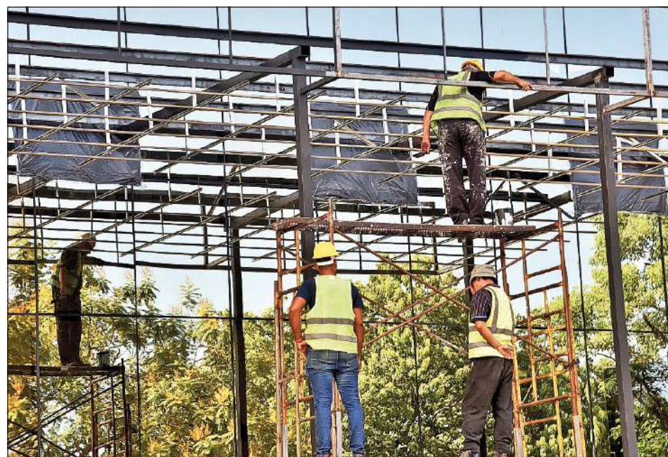
Armado. Trabajadores montando estructuras metálicas en la fachada del Poder Legislativo.
