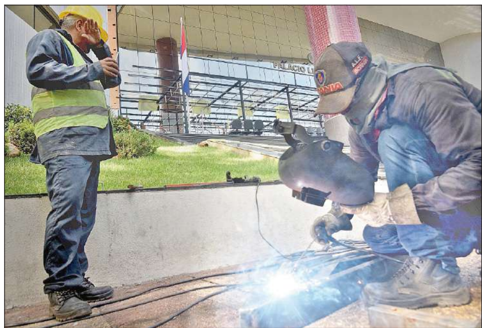
Tareas. Trabajadores soldando herrajes de estructuras frente a la fachada del Congreso.
