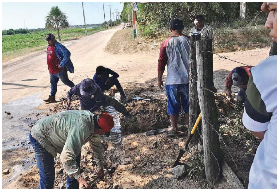
Paliativo. En Carmelo Peralta, excavan para localizar las tuberías y así poder limpiarlas.
