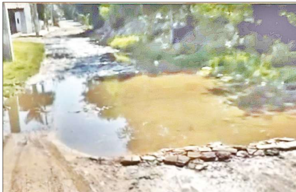
Lambaré. Usuarios de la calle San Juan sufren por fuga de agua a través de cañerías rotas.
