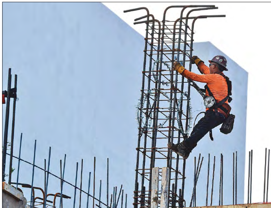
Florida. Un trabajador de la construcción arma una columna utilizando acero.
