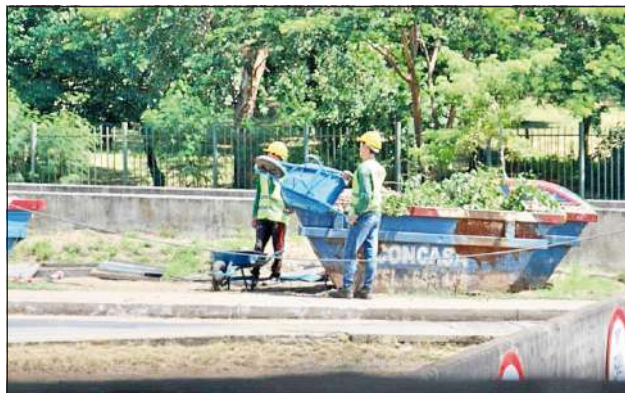
Tareas. Operarios limpian la zona del túnel Itapúa.
