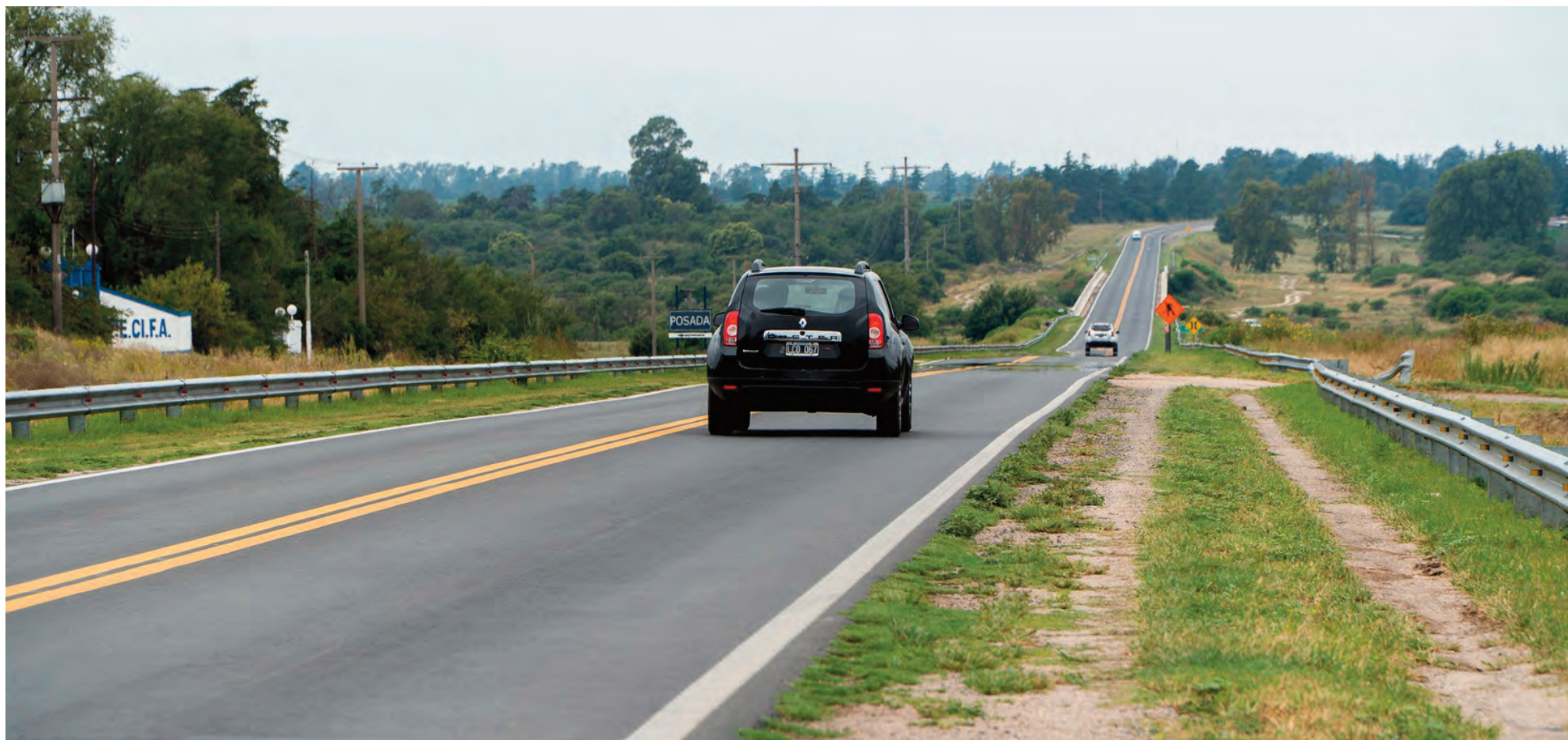
La ruta 8, en su paso por Río Cuarto.
