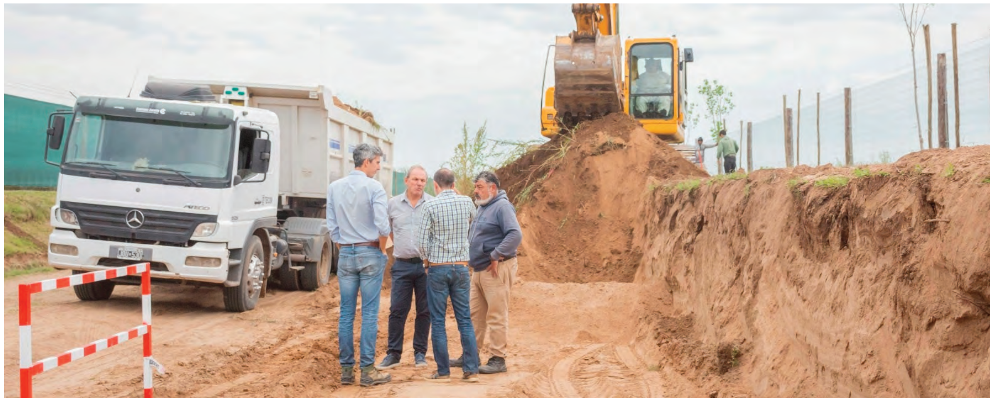
De Rivas, durante la recorrida por la obra.
