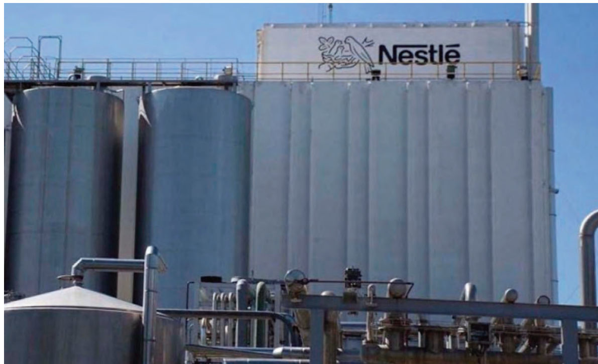
La planta villanovense, según dicen desde Nestlé, produce leche en polvo entera, instantánea y descremada y leche de ultra alta temperatura.
