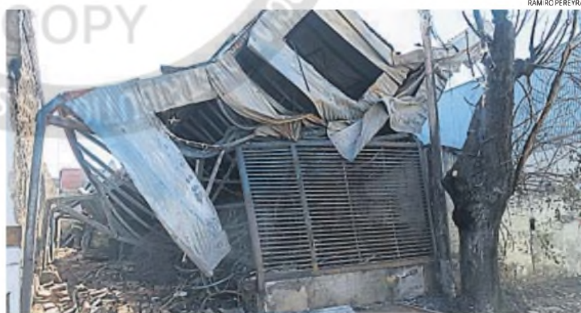
DESASTRE. En pocos instantes, el fuego consumió las paredes de madera, y la estructura de caños y chapas se vino abajo.
