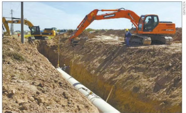
El tramo a ser rehabilitado va desde Puerto Casado a Loma Plata
