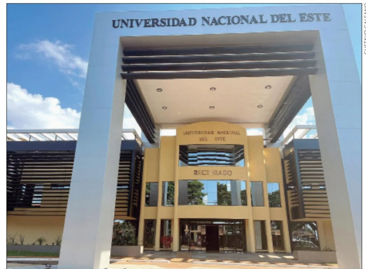
Rectorado de la Universidad Nacional del Este, con fachada nueva
