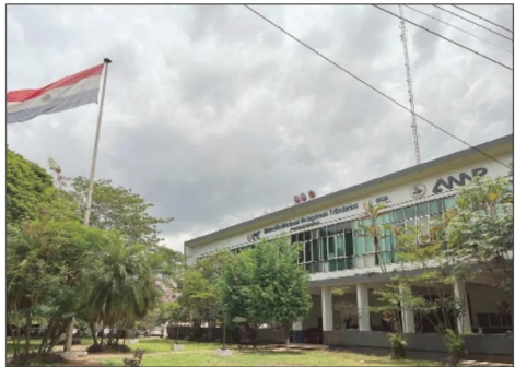
Edificio de la ANNP y Aduana en la cabecera del Puente de la Amistad
