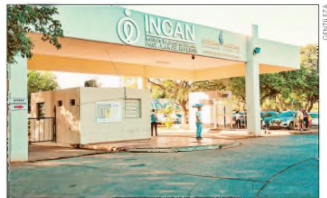
El MOPC será el encargado de supervisar la ejecución de estas obras
