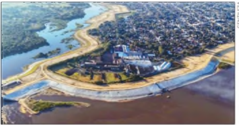
Según el MOPC, la fase B de la Costanera de Pilar generará aproximadamente 600 empleos directos
