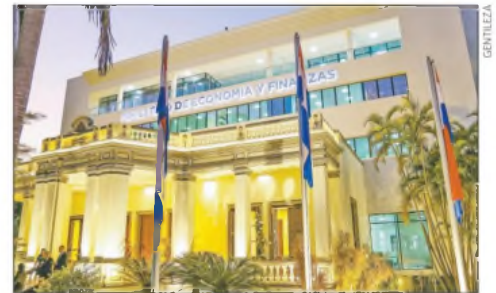
Con la presencia del presidente de la República, Santiago Peña, y otras autoridades, se habilitó esta nueva sede del MEF, ubicada sobre la avenida Mcal. López casi Rca. Dominicana
