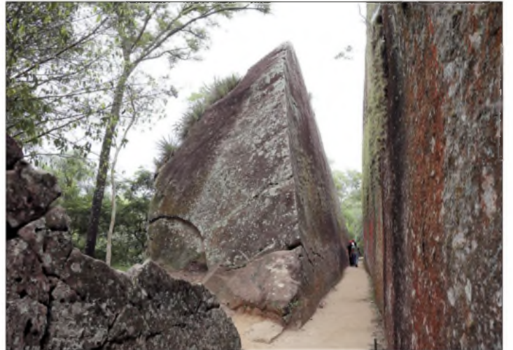
Las secciones A y B están separadas por un callejón formado por la fractura de un macizo rocoso
