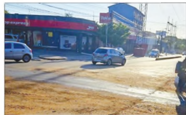
Luego de las obras realizadas sobre la avda. Cacique Lambaré el feriado último, el tramo ya está habilitado al tránsito vehicular
