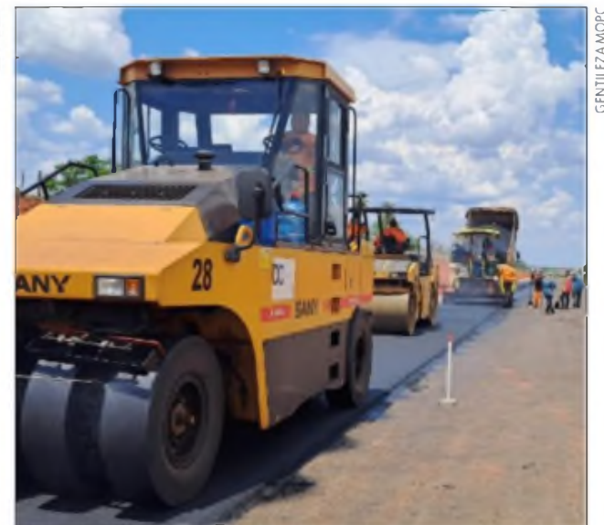
Las maquinarias del MOPC trabajan a tiempo completo en la ruta
