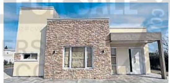
Las casas que construye Domus son con sistema tradicional - mixto, lo que permite aprovechar lo mejor de ambos métodos.
