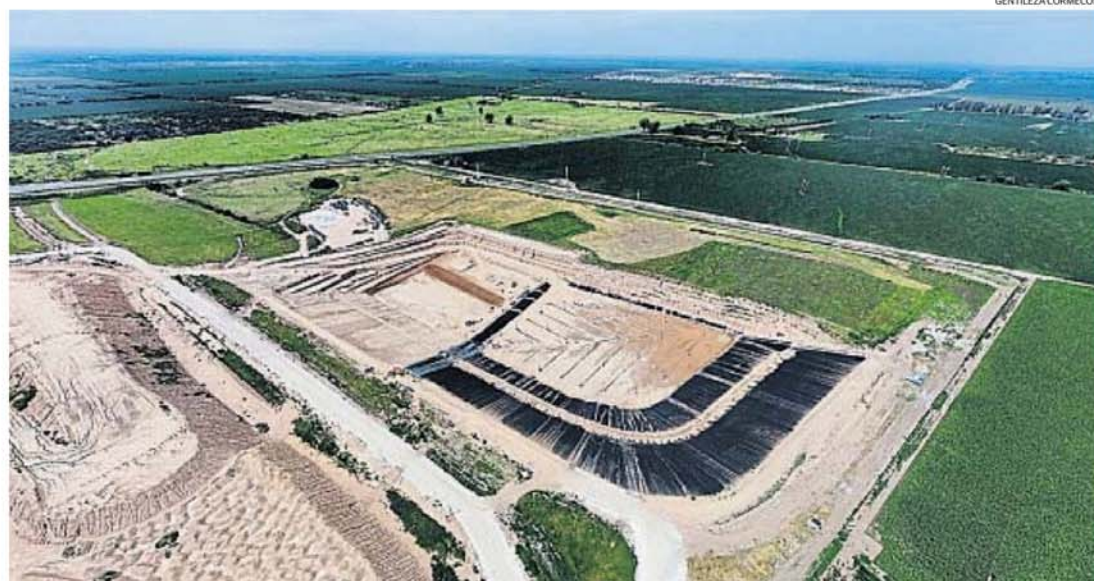
LA GESTIÓN DE LA BASURA. Así son las fosas nuevas del enterramiento sanitario de Piedra Blanca.
