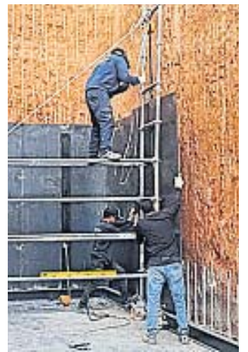
EN OBRA. Trabajadores de la construcción, en plenas labores.
