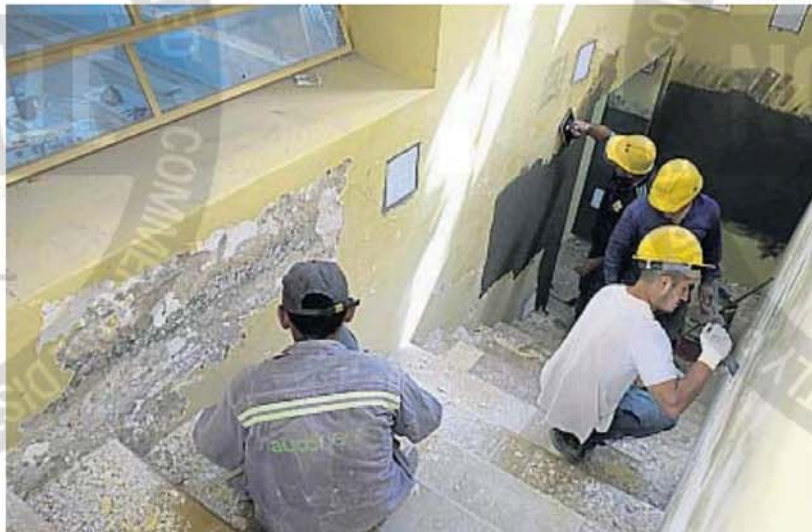
ARREGLOS. Obreros trabajan en las paredes del Ipem 138 Jerónimo Luis de Cabrera, ubicado en barrio Alberdi, a metros del Centro.
