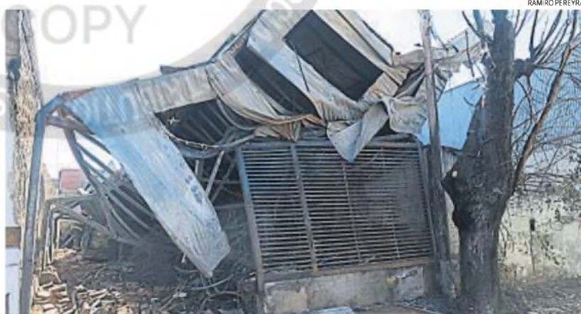
DESASTRE. En pocos instantes, el fuego consumió las paredes de madera, y la estructura de caños y chapas se vino abajo.
