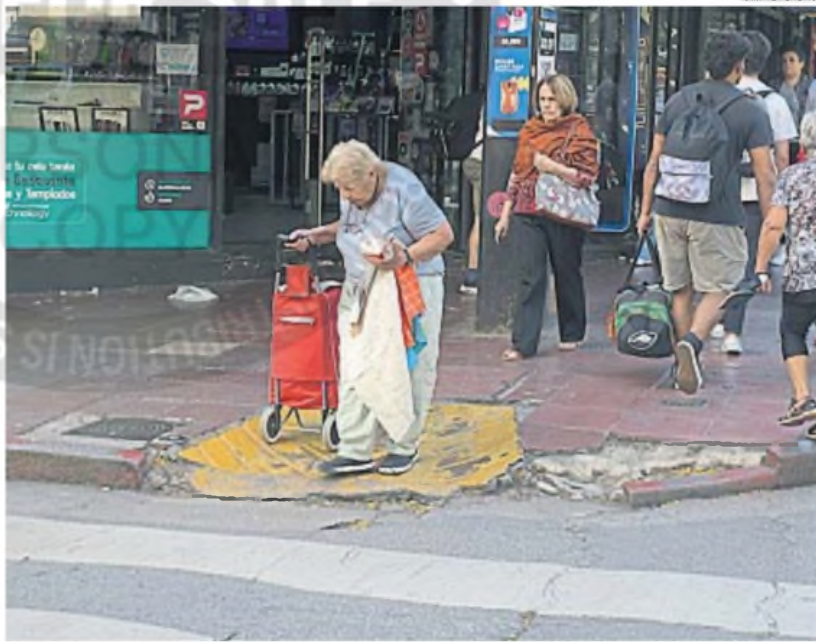
RAMPAS EN MAL ESTADO. Una rampa destruida en la esquina de Obispo Trejo y San Juan. La Municipalidad las reemplazará.
