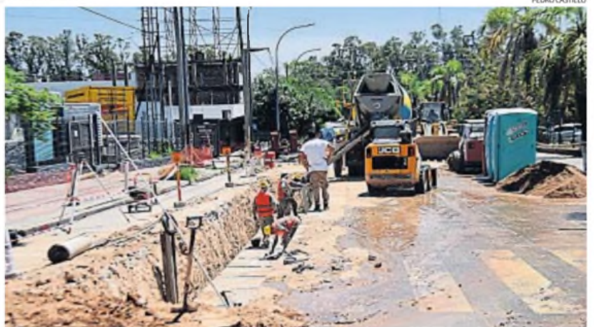
EN TRABAJO. Comenzó la obra que buscará que ya no haya más fuertes corrientes e inundaciones en esta avenida.
