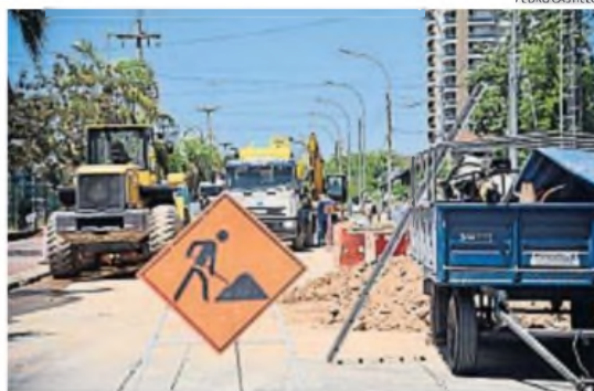
GRAN MOVIMIENTO. Las obras largaron el viernes pasado y durarán 9 meses.
