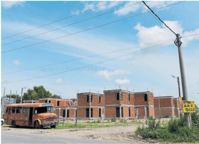
Las obras en el barrio Plátanos, que fueron escenario de la disputa
