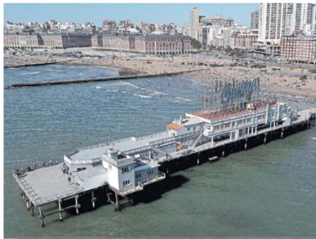
El muelle fue construido simulando un buque que ingresa en el mar
