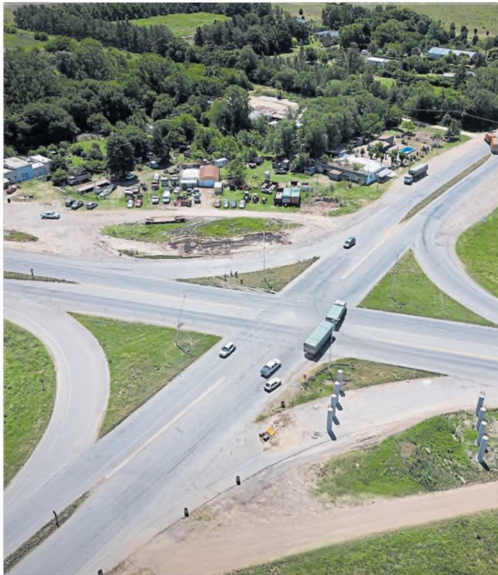
Las obras en rutas y caminos se podrían hacer con mejores precios, plantea el Gobierno MARTIN COSSARINI
