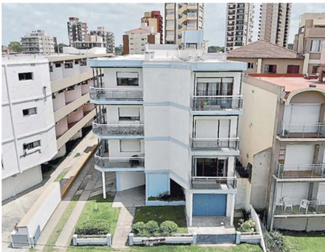
En 2020, en este edificio de Villa Gesell se derrumbaron tres balcones
