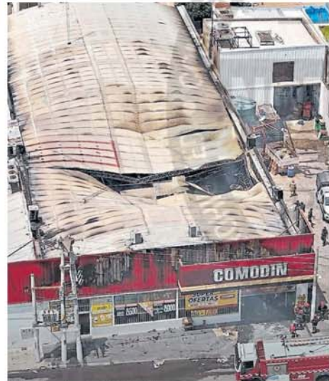
Se desplomó parte del techo del supermercado
