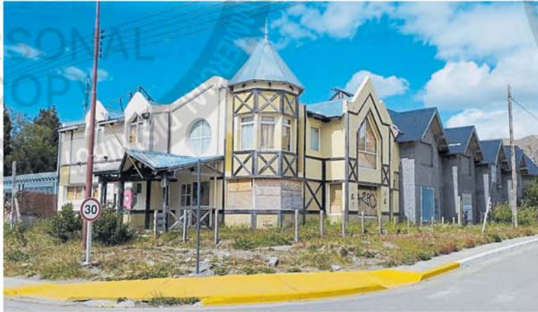
La ocupación irregular del hotel La Aldea dejó sin electricidad a un puesto sanitario local
