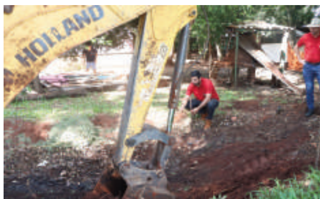
El proyecto cuenta con el apoyo de maquinarias de la Municipalidad.
