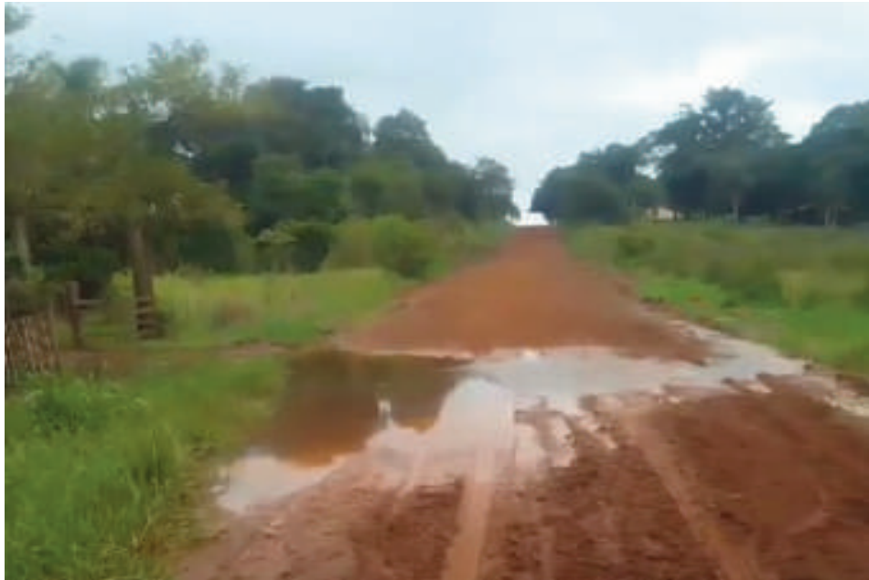
La calle 20 se ve inundada con cada lluvia por falta del desagüe.
