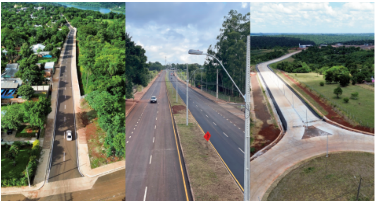
Vista aérea de las labores realizadas en el lote urbano.
