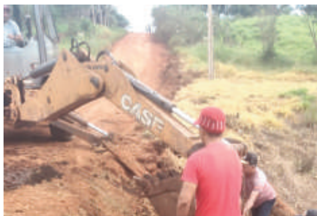
Los trabajos se realizan con ayuda de la Gobernación.
