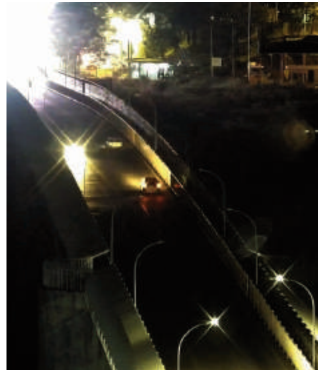
El sistema de iluminación necesita de una urgente reparación.
