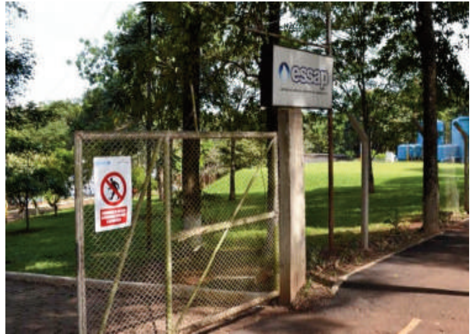
Planta de Tratamiento de Agua de la ESSAP.
