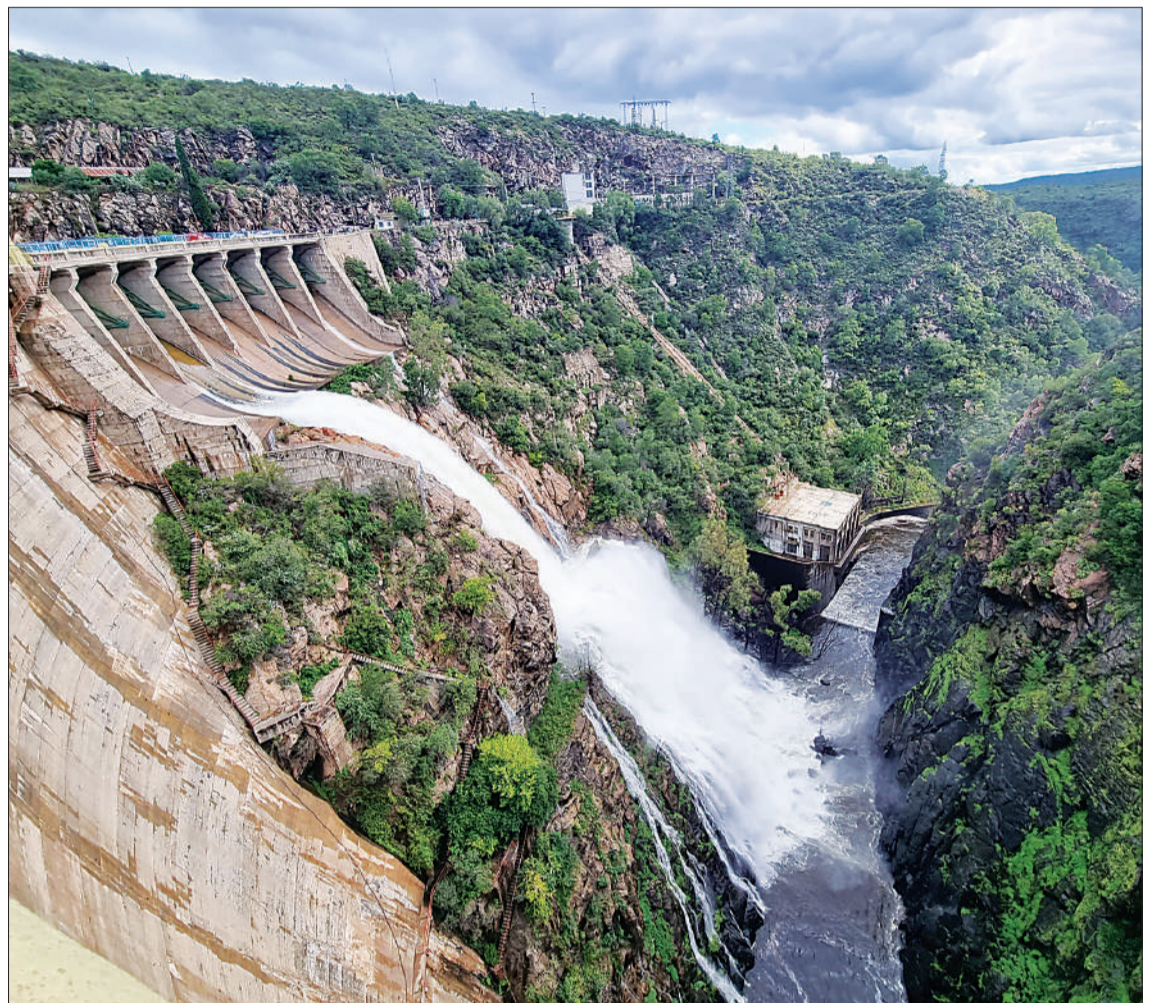
En el caso del Dique La Viña, se realizó una prueba de funcionamiento de las compuertas.
