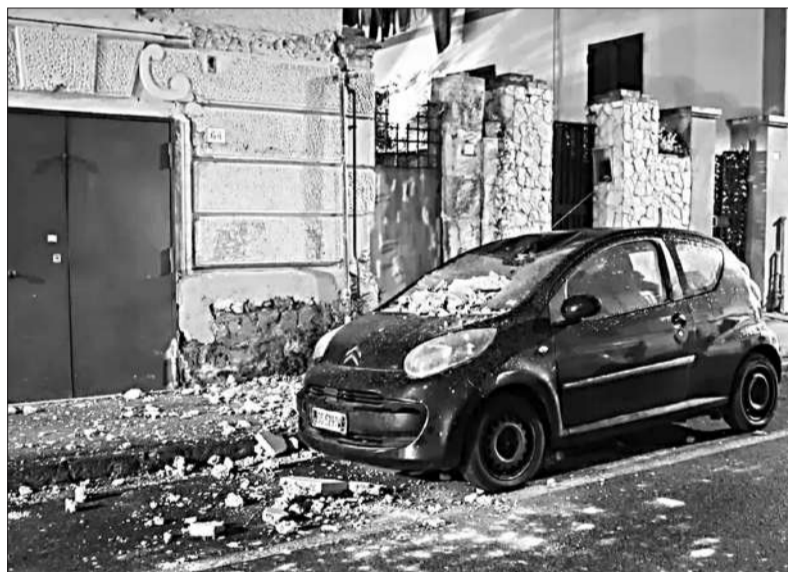
Los autos fueron alcanzados por la caída de escombros debido al sismo.
