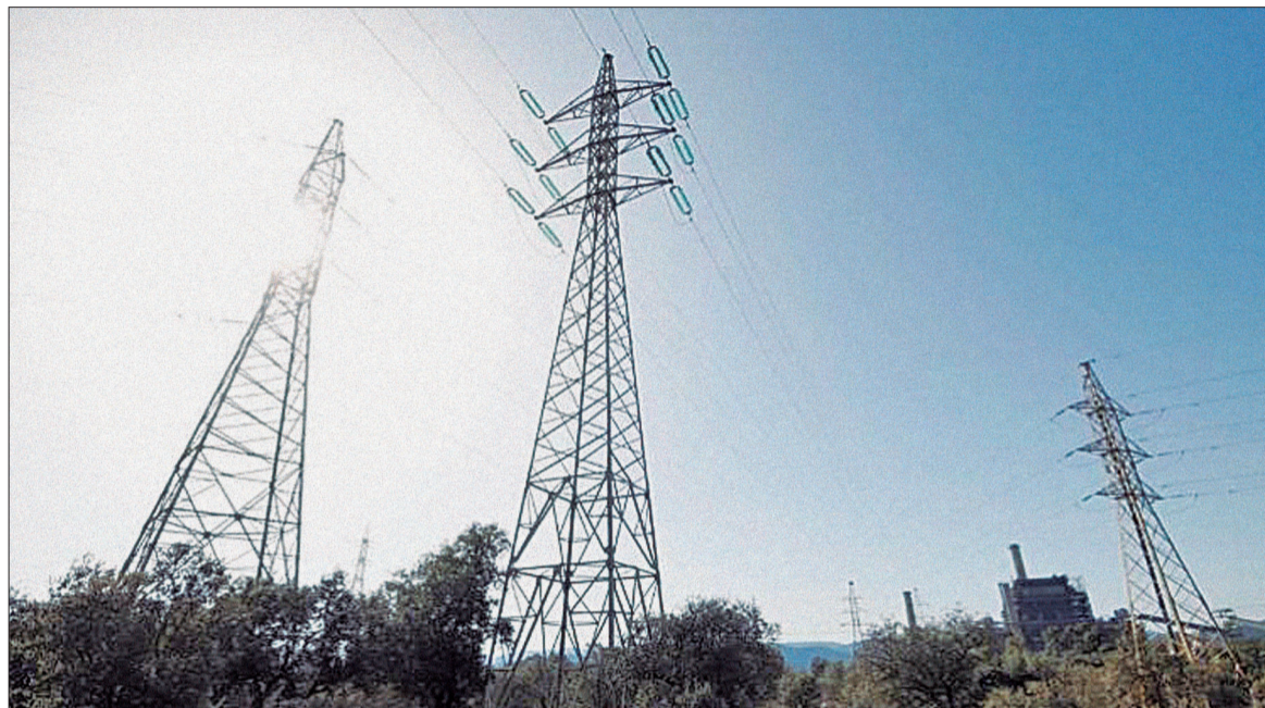
La falla que provocó el corte, según Epec, se debió a un problema en el sistema de líneas de alta tensión.
