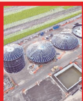
PELIGRO. Hay muchos incineradores ilegales.
