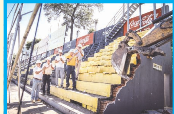
DERRUMBE. El club Guaraní mostró imágenes del inicio de la demolición de su estadio de Dos Bocas, que será remodelado en su totalidad.
