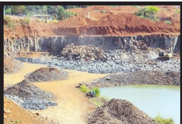
PIDEN CLAUSURAR CANTERAS. Los vecinos del barrio Santa Inés de Presidente Franco (Alto Paraná) exigen cerrar definitivamente las canteras Roca Negra, Itamí y Monday, porque las explosiones mineras generan fisuras en sus viviendas, escuelas e iglesias de la zona.
