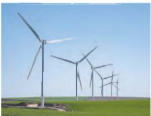
Parque Eólico La Elbita
