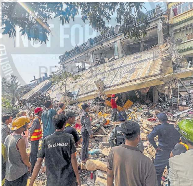
Desplome. Una edificio completamente volteado sobre una montaña de escombros en Mandalay. EFE
