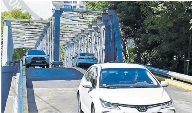
Liberado. Los autos comenzaron a circular ayer sobre el puente que cruza las vías del tren Mitre. M. CAMPAYA
