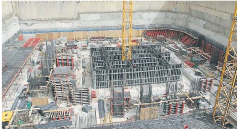
Zona de obras. Las obras que se están iniciando son aptas para el blanqueo si tienen un avance de 50%.
