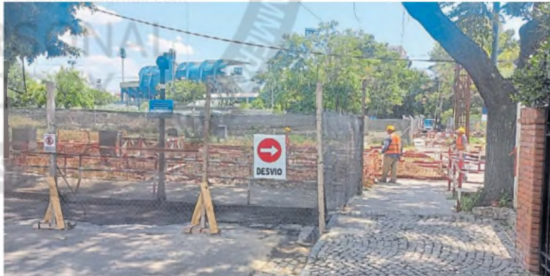
Alternativa. Durante la construcción del túnel, se podrá cruzar la vía por Martín de Gainza, la paralela.
