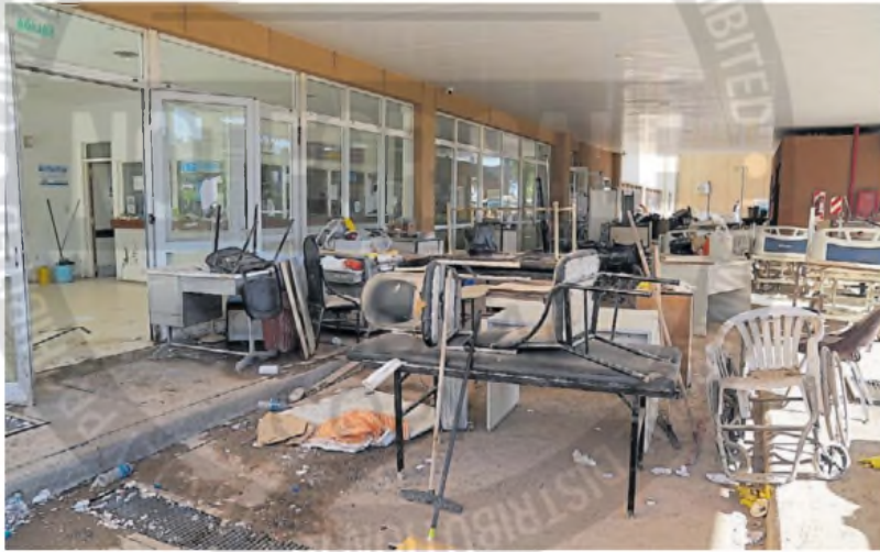
Volver a empezar. El hospital Penna y los destrozos que dejó la inundación. JUANO TESONE / ENVIADO ESPECIAL
