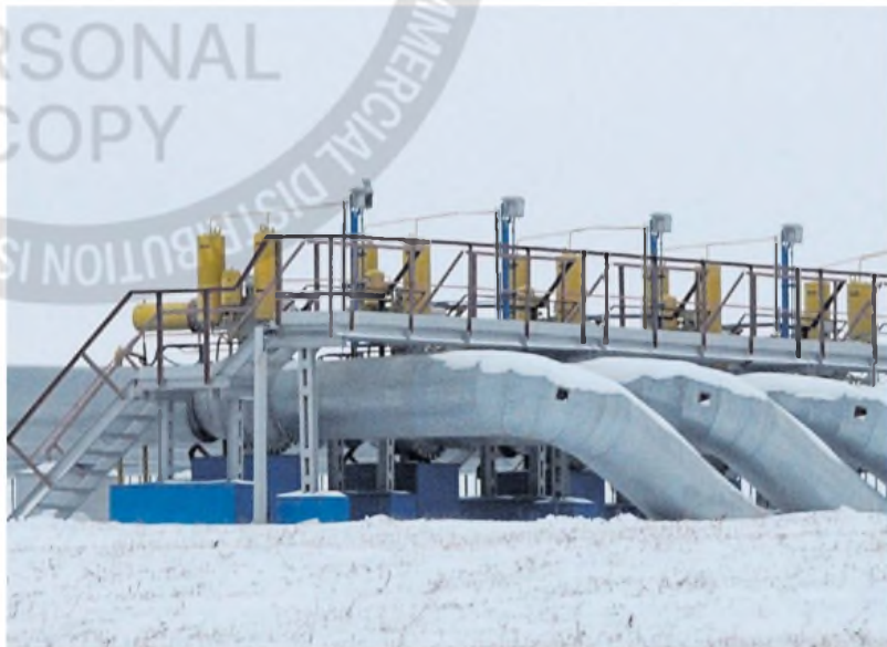
Tuberías. La estación de gas de Sudzhe, en Rusia. Los soldados rusos usaron tuberías para atacar. AP
