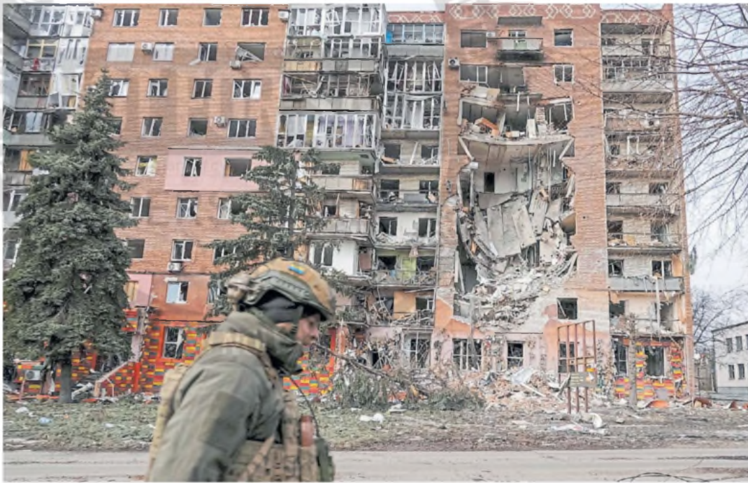
Desastre. Un soldado ucraniano pasa frente a un edificio de departamentos muy dañado por los ataques rusos en Pokorvsk, Donetsk. REUTERS
